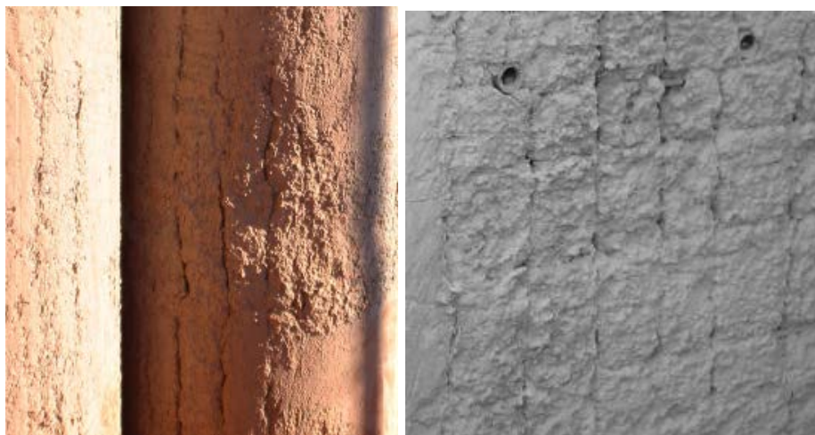
Abbildung D.5: Schattenbildung an einem Pfahl ( links ); Schattenbildung an einem Schlitzwandelement ( rechts )
