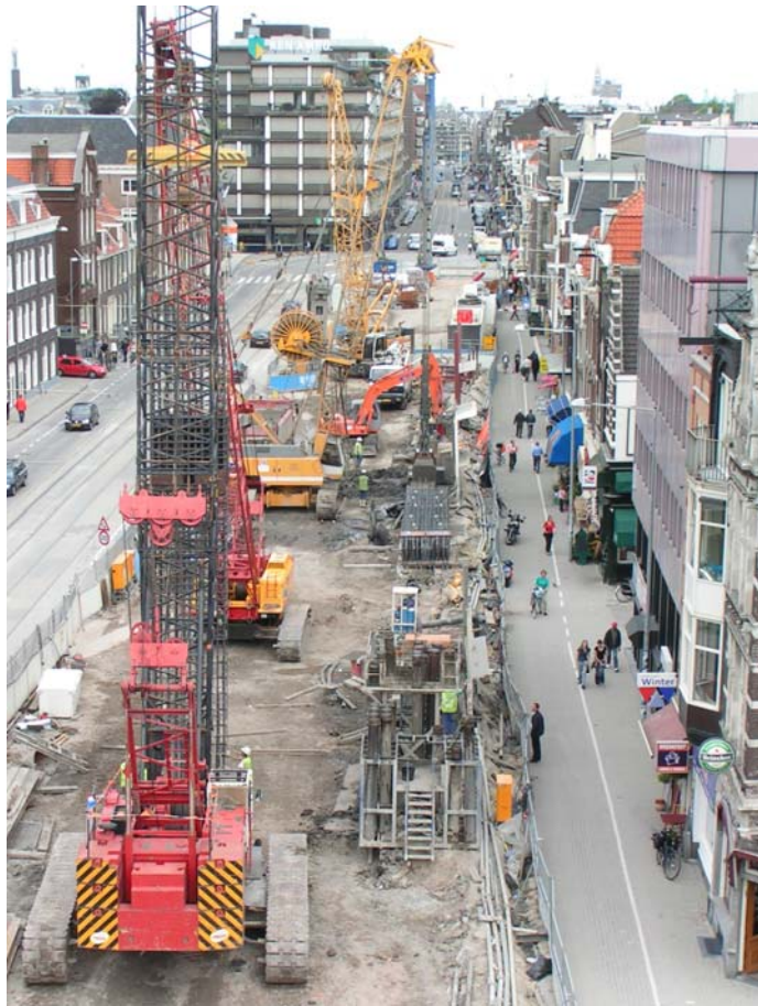
Fig 2: Die Passanten gehen oft auf der anderen Seite des Baustellezaunes vorbei, ohne jede persönliche Schutzausrüstung
