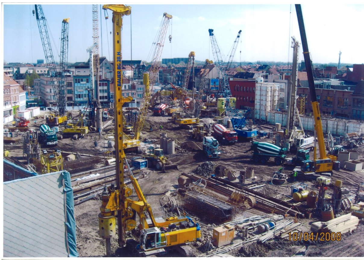
Fig 1: un chantier encombré nécessite une direction de chantier très qualifiée et professionnelle, et de la coordination
